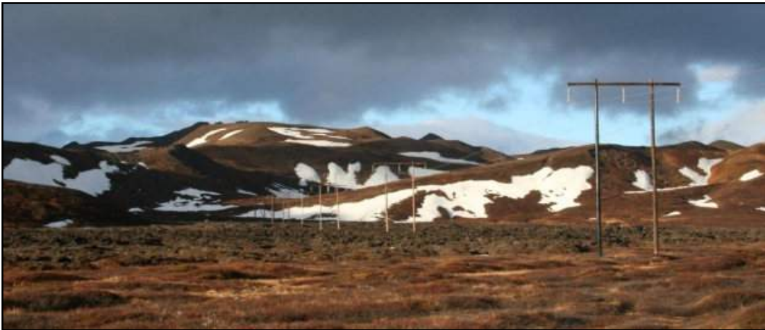
Kröflulína 2 þar sem hún liggur vestan við Kröfluveg og inn Hlíðardal.
