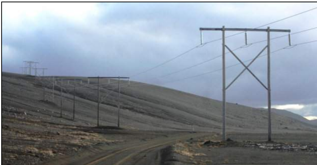
Ekið undir Kröflulínu 2 við Ferjuás á Öskjuleið (F88).
