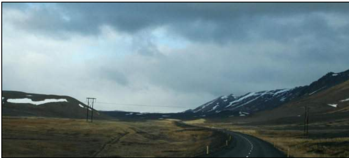
Kröflulína 2 þverar Víðidal. Kröflulína 3 mun hér liggja um 500 metrum sunnar (aðeins að baki ljósmyndara sökum þrengsla í Sauðaskarði.
