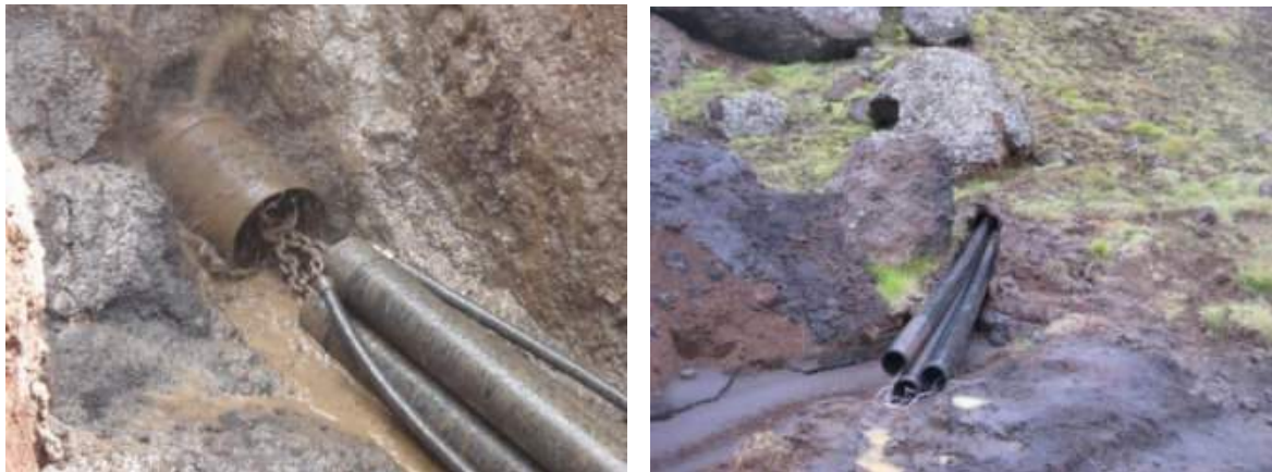
Mynd 3.7. Stefnuborun við Dyradali, vegna lagningar Nesjavallalína 2 (2009).
