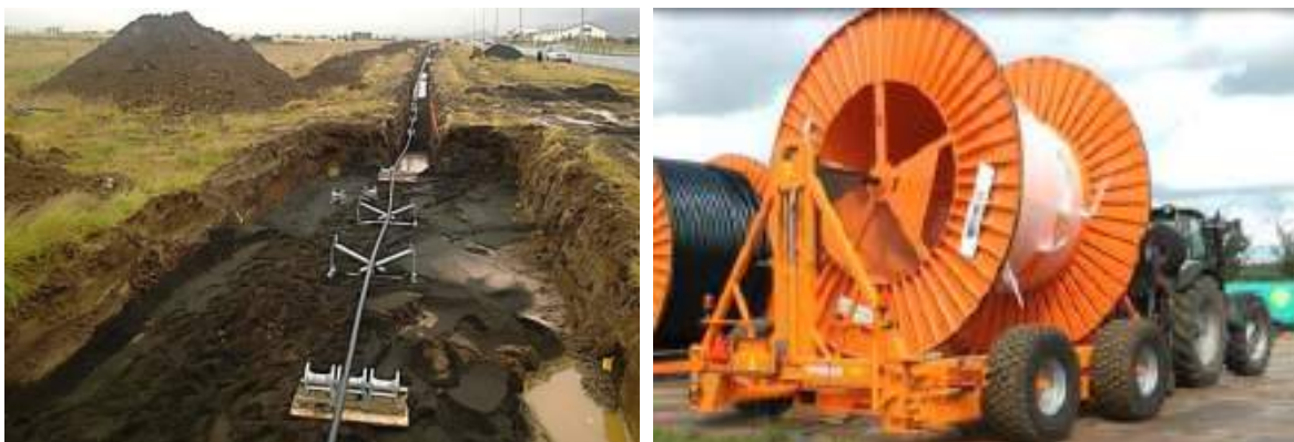
Mynd 3.2. Útdráttur háspennustrengja í opinn skurð.
